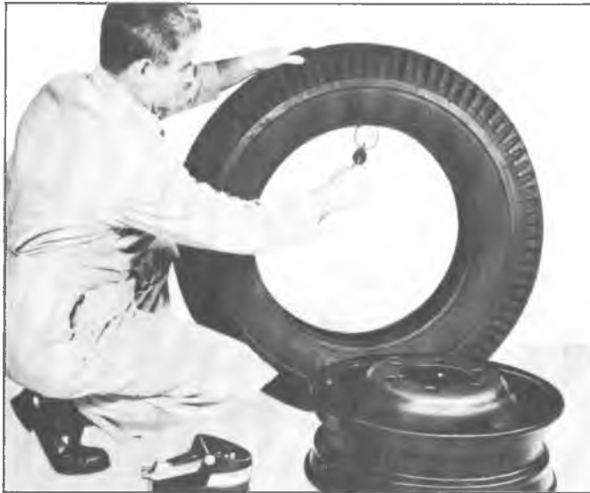
Fig. 8—Lubricating Tire Bead
